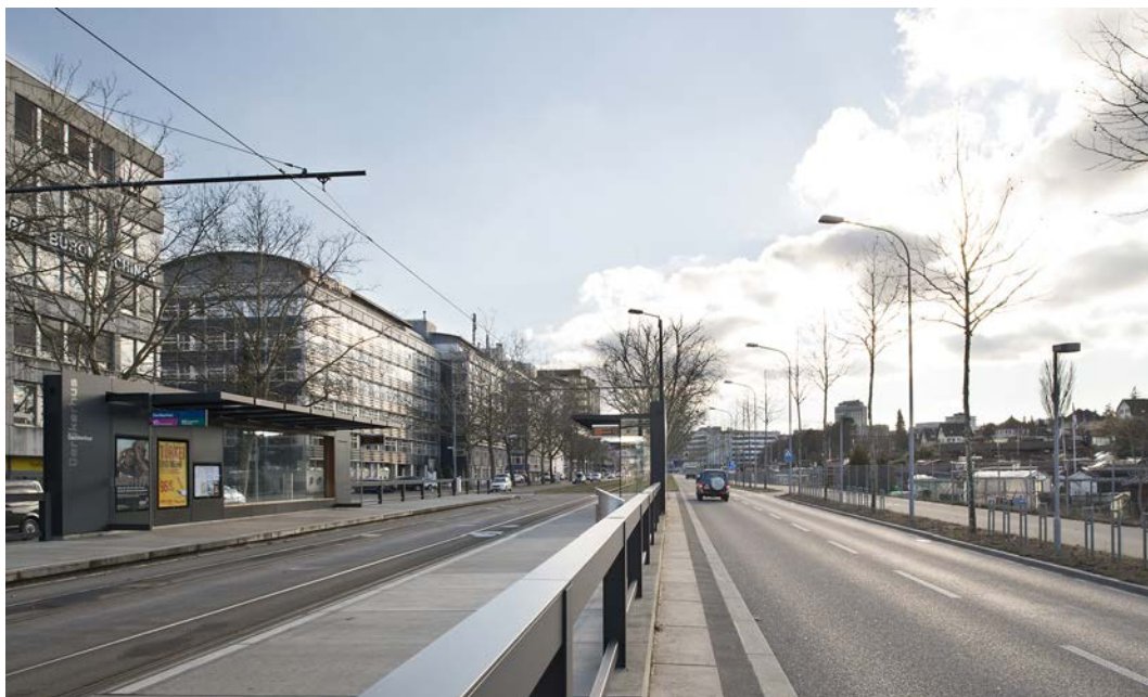
Trassee Glattalbahn und Strassenraum Thurgauerstrasse (Haltestelle Oerlikerhus)
